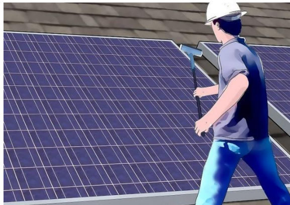
ภาพที่ 29 การบำรุงรักษาแผงโซลาร์เซลล์ (Solar Panels)
