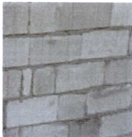
ภาพที่ 24 การก่อและยึดคอนกรีตบล็อกผสมผงเซรามิกเหลือทิ้งเป็นผนังด้วยปูนก่อ
