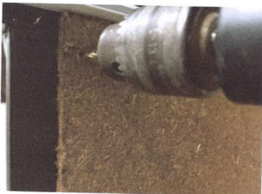
รูปที่ 21 การเจาะแผ่นขึ้นไม้อัดด้วยสว่านไฟฟ้า
