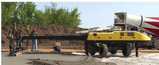
ก) เครื่องจักรปรับระดับพื้นเชิงพาณิชย์แบบเครื่องจักรหยุดนิ่ง
