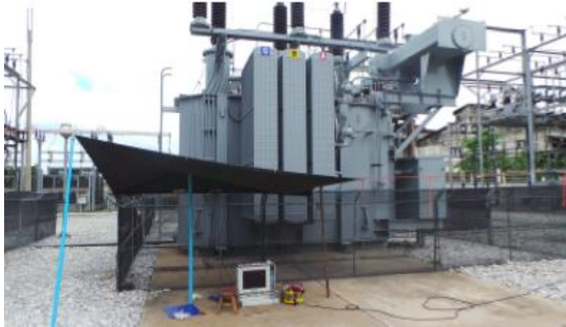
ภาพที่ 4 การติดตั้งเครื่อง PDC-ANALYSER-1MOD เพื่อทดสอบ
