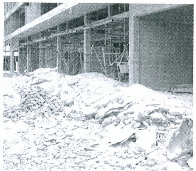
(ข) สภาพวัสดุสิ้นเปลืองภายหลังการก่อสร้าง
